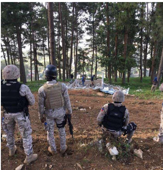
Support du gouvernement dans la démolition des structures illégales dans le bosquet de la WF
