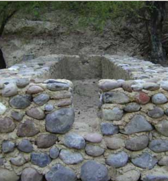
■ Figura 4. Proceso de construcción del biodigestor (fotografía de Luis Sáenz Villa).
