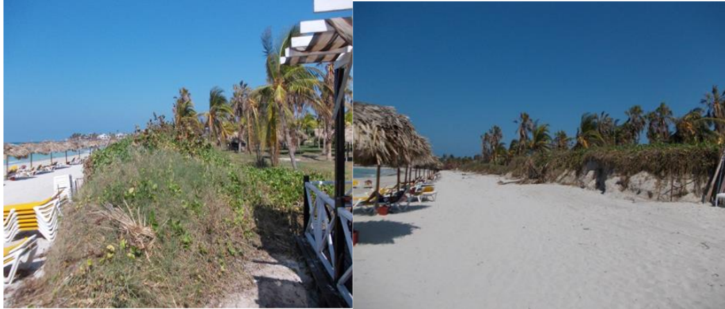
Figura III.10.e.11. Duna y frente costero del hotel Iberostar en Varadero después del paso del huracán Irma.
