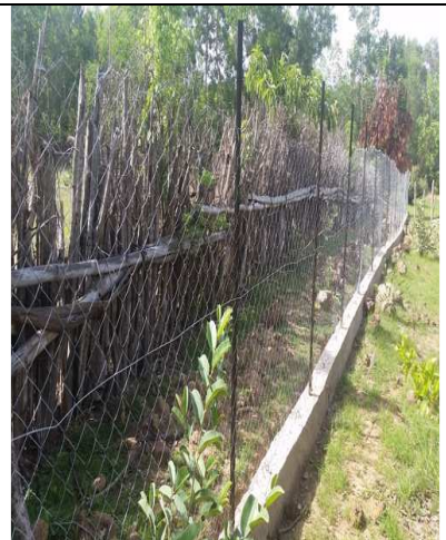
Clôture grillagée pour remplacer la clôture en bois dans le village de Kansagnel / Timbi-Touni / PITA
