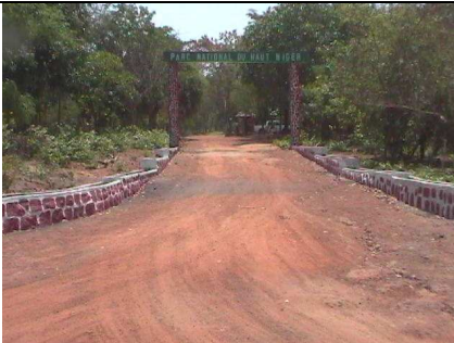
Arche du Parc du Haut Niger
