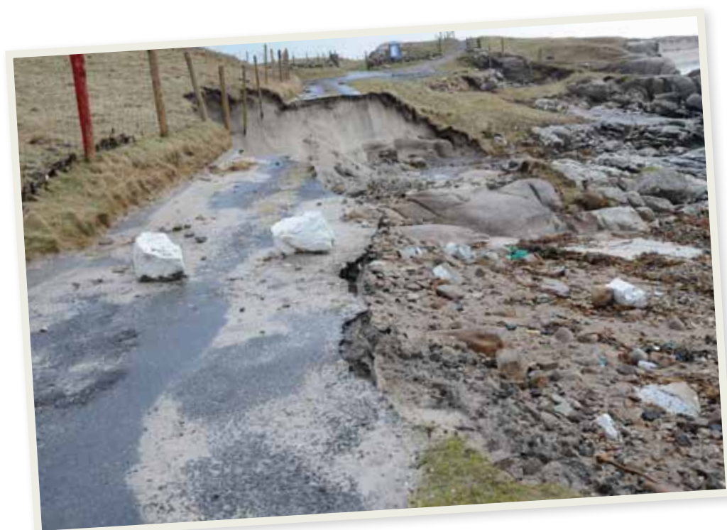
2015 storm damage Galway (Karen Gaynor) ↻
