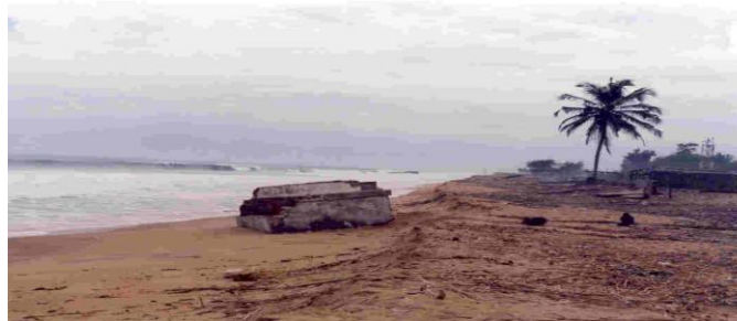
Figure 10. Erosion des plages à Port-Bouet (pilonne abandonné de l'ancien wharf)
