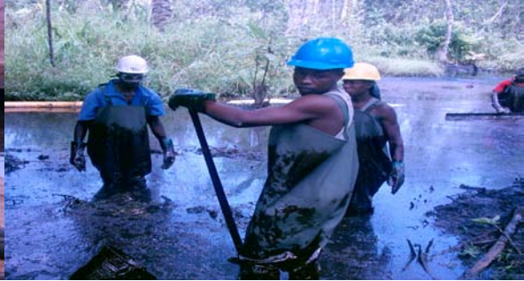
photo 6 : dépollution du site
