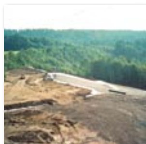
• Průběh sanace skládky v obci Kozly
